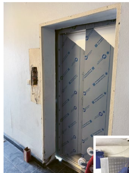
Während der Umbauphase: Einbau der neuen Aufzugskabine und des neuen Antriebsmotors
