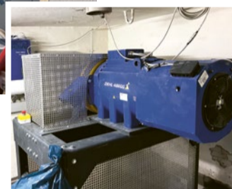
Während der Umbauphase: Einbau der neuen Aufzugskabine und des neuen Antriebsmotors
