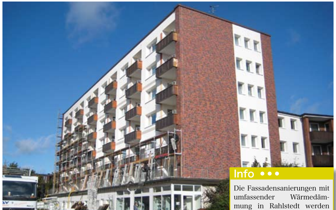
Fassadensanierung in der Döpheid 22
