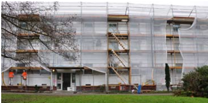
Fassadensanierung Neuköllner Ring 36
